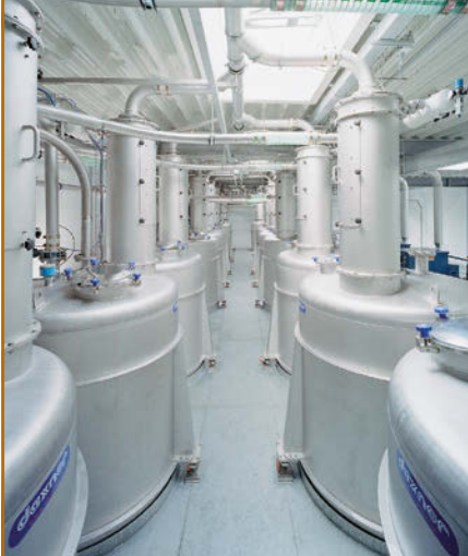
Abb. 2: Tagesbehälter zur Vorlage von Komponenten wie Milchpulver, Kakaopulver, Zucker etc. werden pneumatisch, unter Verwendung von gekühlter und getrockneter Förderluft beschickt.
