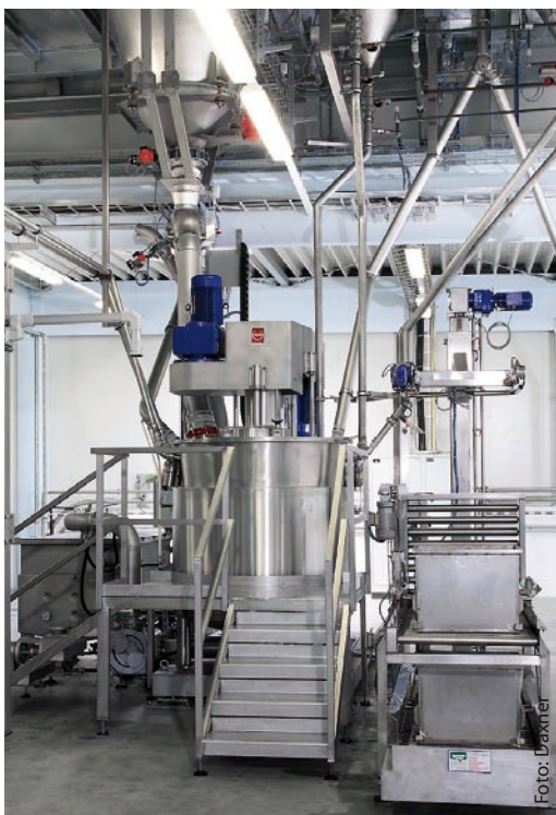
Zuführung der Pulver- und Flüssigkomponenten in den Dissolvmischer.
