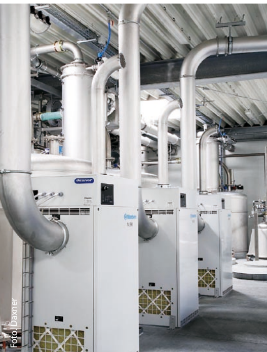
Konditionierte Luftaufbereitung für pneumatische Druckförderung
