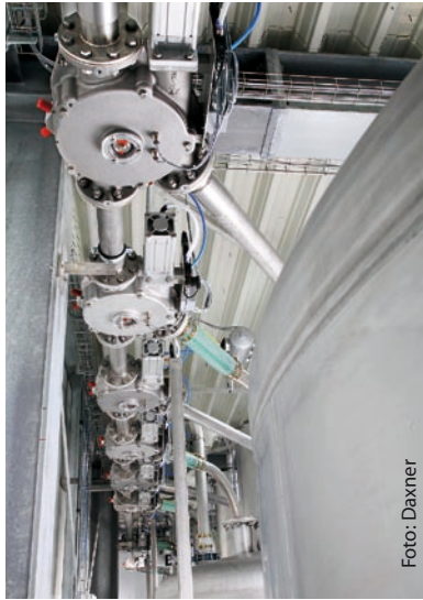
Produktverteilung zu den Tagesbehältern mittels Drehschieberrohrweichen
