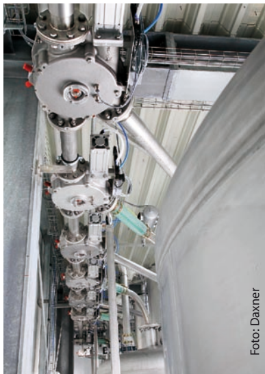
Produktverteilung zu den Tagesbehältern mittels Drehschieberrohrweichen
