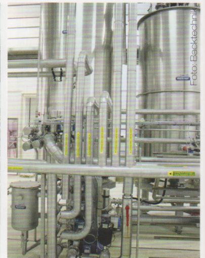
Bild links: In zwei Reifebehältern hat der Vorteig Zeit sich zu entwickeln. Links im Bild der große, gekühlte Lagertank. Bild Mitte: Bevor der Vorteig in den Lagertank fließt, wird er im Plattenwärmetauscher auf fünf Grad Celsius heruntergekühlt. Bild rechts: Ein umfangreiches Kühlsystem sorgt dafür, dass die einzelnen Komponenten die gewünschte Temperatur aufweisen.
