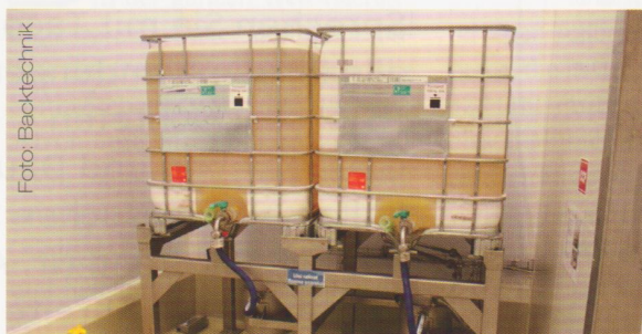
Bild links: Zwei Tanks sorgen für die ausreichende Menge an Öl, das über eine Pumpe zum Anteiger und Knetter gefördert wird. Bild rechts: Die Hefe wird zunächst aufgelöst und anschließend in den nebenstehenden, gekühlten Lagertank gepumpt.
