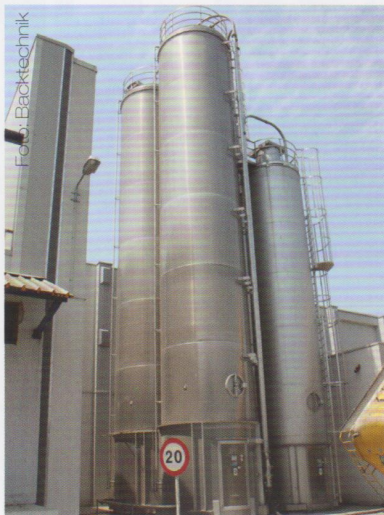
Bild links: Das 30 Tonnen Zuckersilo und die drei 50 Tonnen Mehlsilos befinden sich im Außenbereich der Bäckerei. Das Mehl für die Produktion liefert die zum Konzern gehörige Mühle. Bild Mitte: Sowohl die Kleinkomponenten als auch Mehl und Zucker müssen vor der Verarbeitung gesiebt werden, um Verunreinigungen auszuschließen. Bild rechts: Während in der unteren Waage das Mehl der kontinuierlichen Vermischung zugeführt wird, kann in der oberen Waage das nächste Batch abgewogen werden.
