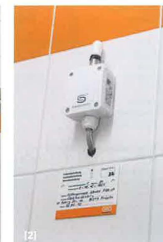
[1] Der 100 Kilogramm Mehl fassende Wiegebehälter ist an einer zentralen Wiegezone aufgehängt. [2] An der Rückwand der Teigmacherei misst ein Fühler die Raumtemperatur, mit der die Steuerung unter Berücksichtigung der Mehltemperatur die korrekte Schüttwassertemperatur errechnet. [3] Neben der rezeptgesteuerten Verwiegung ist selbstverständlich auch die Handeingabe gewünschter Mehl- oder Wassermengen möglich. Auch die derzeitige Füllmenge des Silos wird angezeigt.
