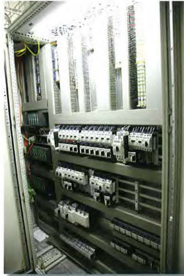
Für das Zusammenspiel aller Komponenten der komplexen Rohstoffdosierung sorgt ein großer Schaltschrank, der unter anderem die einzelnen Motoren, Ventile und Klappen steuert.
