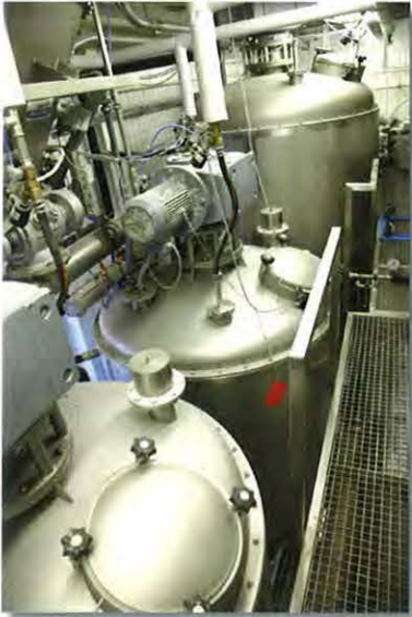
Die in die Rohstoffdosierung integrierte Sauerteiganlage besteht aus einem 4.000 l-Lagertank und zwei parallel arbeitenden Reifebehältern mit je 2.500 l Fassungsvermögen.
