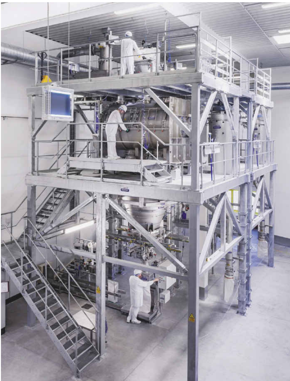
Das Lübecker Unternehmen Katech hat Daxner mit der Planung, Lieferung und Montage einer gravimetrischen Mischanlage mit zwei getrennten Mischlinien beauftragt
