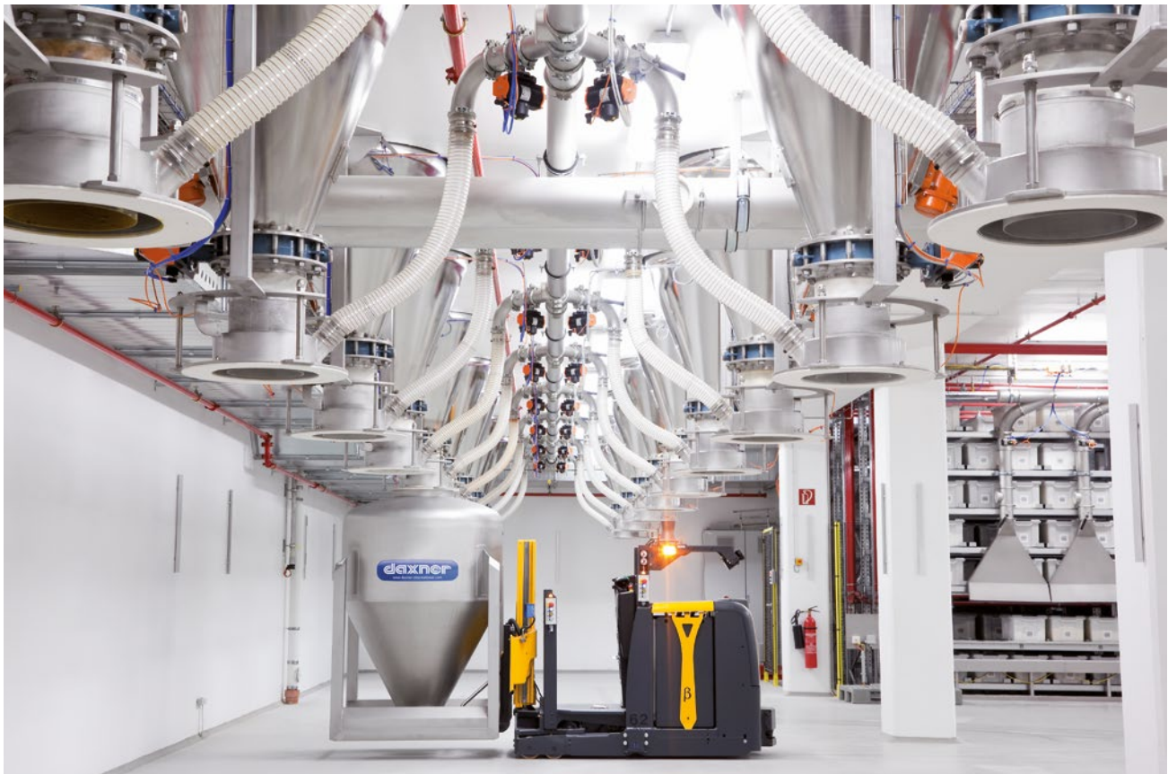
Vollautomatisches Absammelsystem mittels Daxner Container Systems DCS in Verbindung mit FTS System (Fahrerloses Transportsystem)
