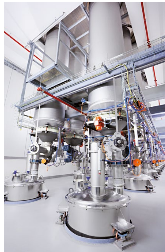
Tagessilos mit Vibroaustragboden Behälterwaagen 500 l, Hygienic Design; elektropoliert für hohe Wiegegenauigkeit
