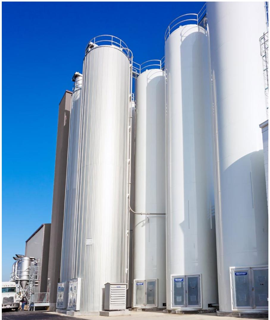
Großkomponenten werden in Außenlagersilos gelagert und pneumatisch den Mischlinien zugeführt
