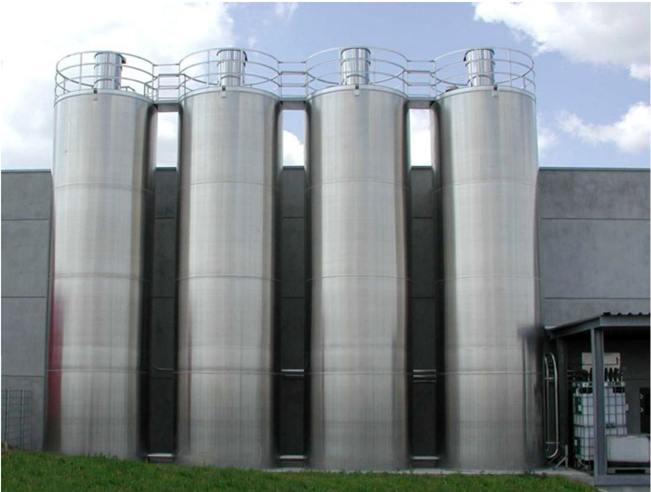
Jeder der vier aus Aluminium gefertigten, runden Außensilos hat ein Fassungsvermögen von 30 Tonnen Mehl.
