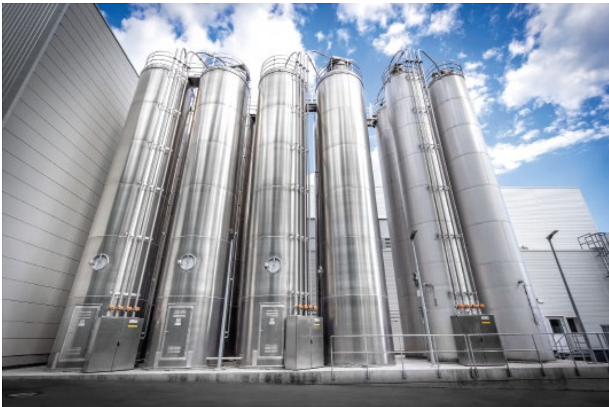
Die Hauptkomponenten werden in Außensilos gelagert und pneumatisch den Mischlinien zugeführt.
