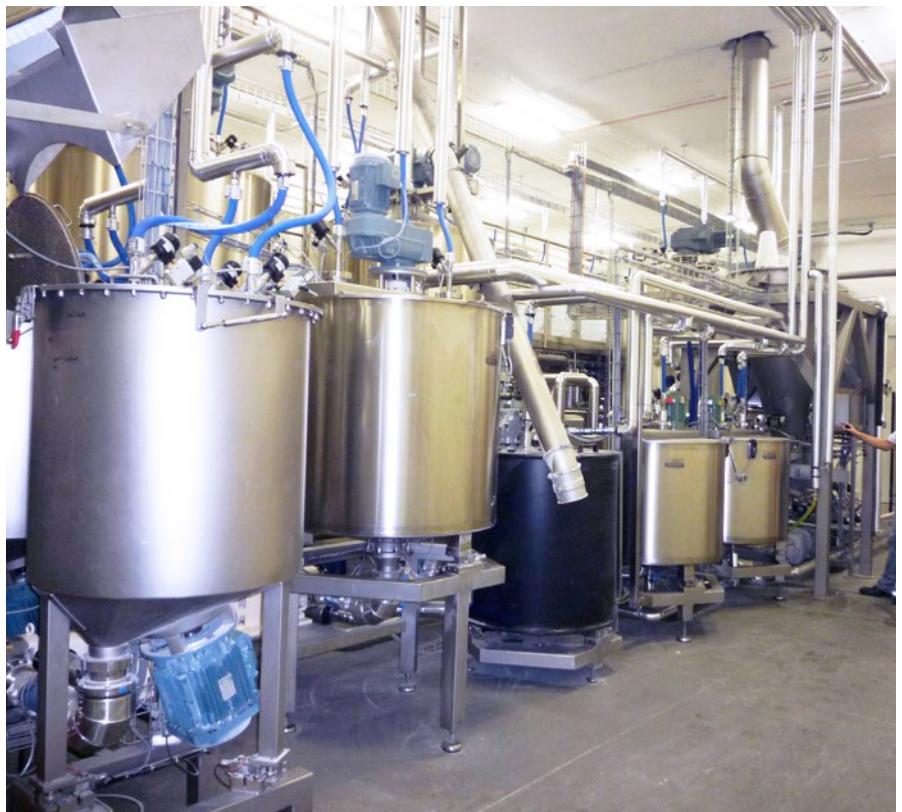
Unterschiedliche Anschlüsse, wie Wasser und Volumenkontrolle werden benötigt, um den automatisierten Prozess reibungslos zu steuern. Die letzten Kapazitätserweiterungen bei der Herstellung von Sauerteig um jeweils zwei Tanks erfolgten in den Jahren 2012 und 2013.
