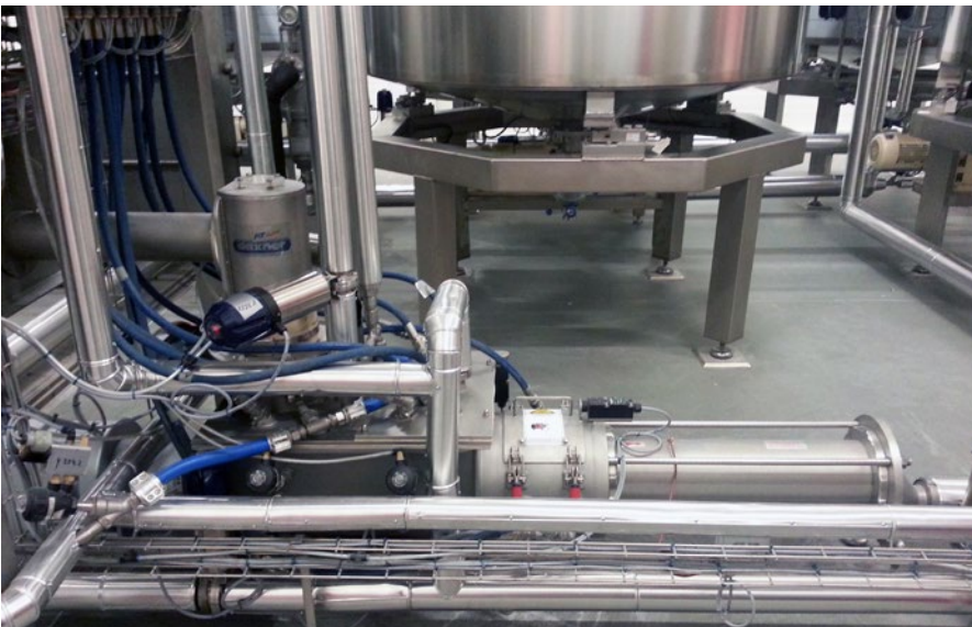
Alle Tanks sind auf Wägezellen montiert, um die ablaufenden Prozesse genau zu steuern. Der Anteiger vermischt die einzelnen Komponenten des Weizenvorteigs mithilfe einer Mischerschnecke zu einer homogenen Masse.
