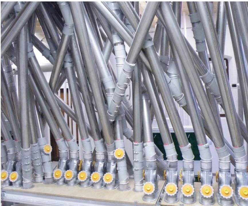
Für den Rohrbau entwickelte Daxner eine Kombination aus Sallhofer-Baukastensystem mit Edelstahlrohren, welche den hohen Hygieneanforderungen standhält.
