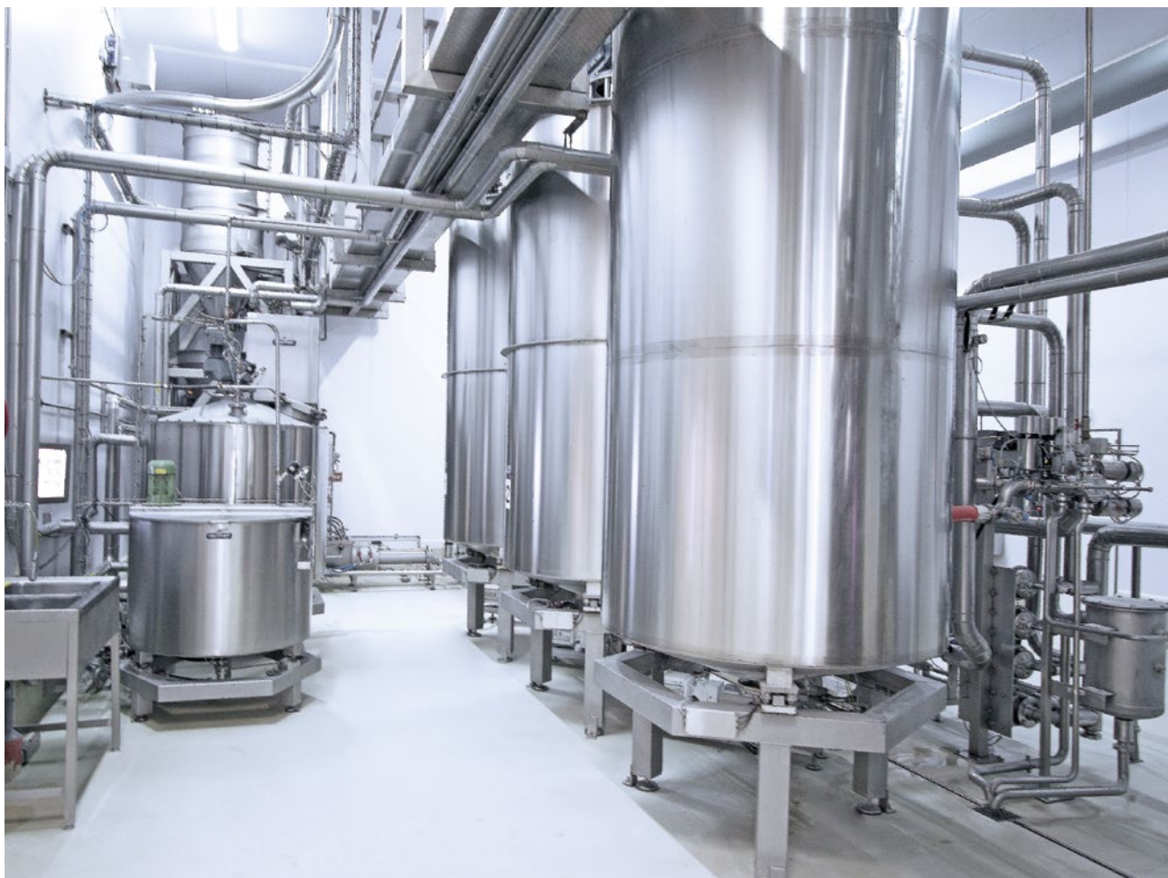
Die Anlage von daxner überzeugt nicht nur optisch, mindestens genauso viel Fachwissen steckt in der Technologie und der intelligenten Steuerung.
