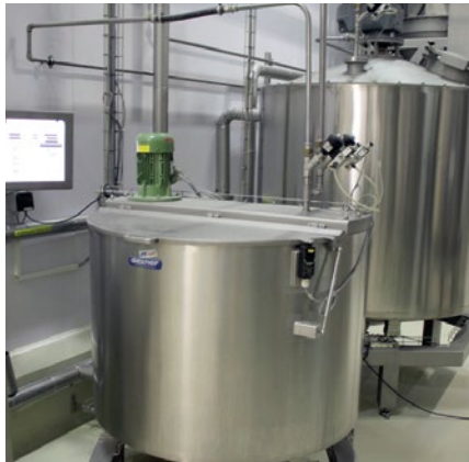
Die Hefe wird zunächst aufgelöst und anschließend in den nebenstehenden gekühlten Lagertank gepumpt.
