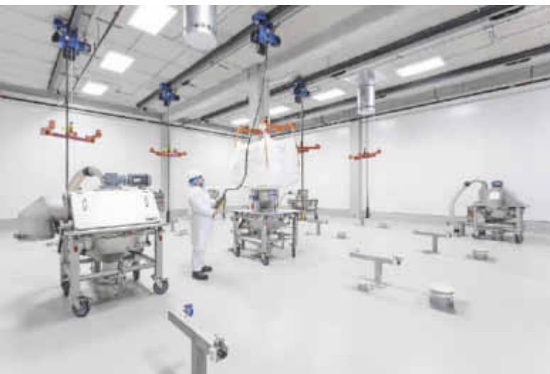
Die Mittelkomponenten befinden sich in Tages-silos. Sie werden mithilfe von mobilen Aufgabestationen mit integrierten Kontrollsiebmaschinen befüllt.
