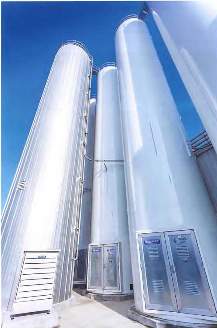
Abb. 1: Großkomponenten werden in Außensilos gelagert und pneumatisch den Mischlinien zugeführt.
