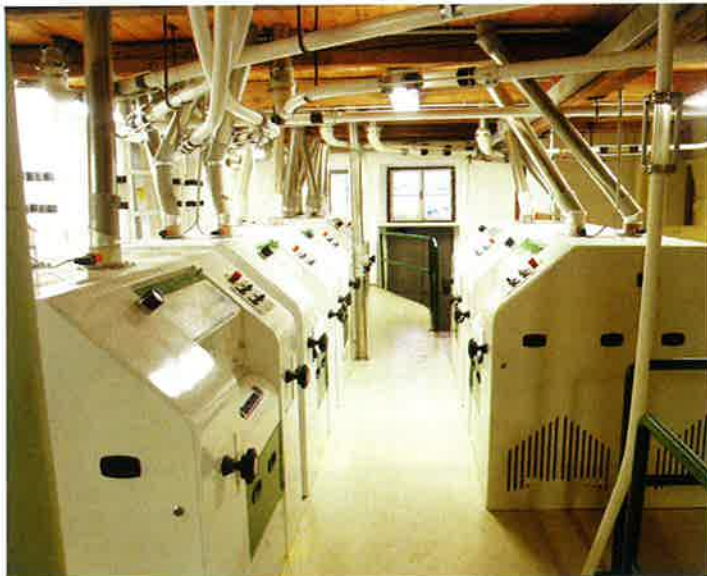
Abb. 3: Die Lerchenmühle wurde mit sechs neuen Walzenstühlen der Baureihe „Phenomill“ ausgestattet.
