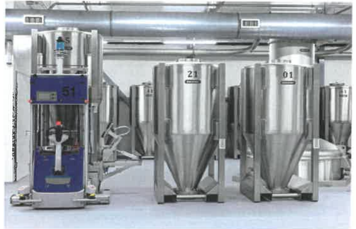
Abb. 2: Automatischer Containertransport mit fahrerlosem Transportsystem FTS
