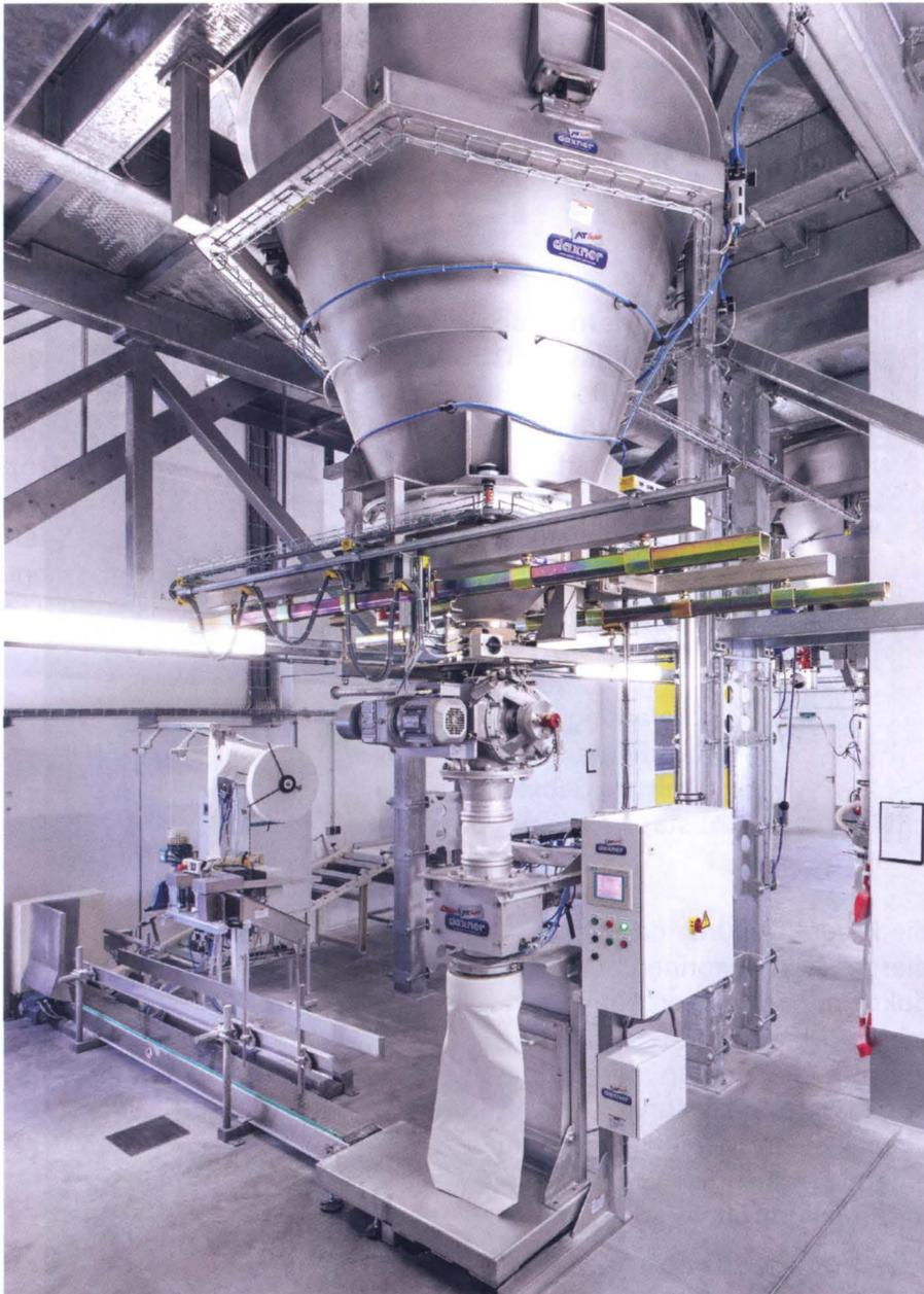
**Gravimetrische Absackwaage DAX-PVS zur Abfüllung der fertigen Mischung in Verkaufsgebinde**
