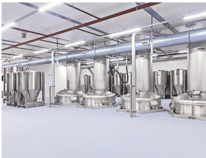
Behälterwaagen über den High-Performance-Mischlinien
