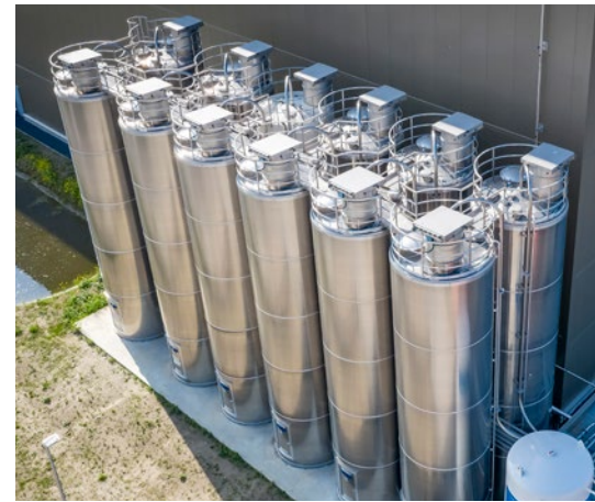
Weithin sichtbar sind die 12 Außensilos zur Lagerung der Hauptkomponenten.
