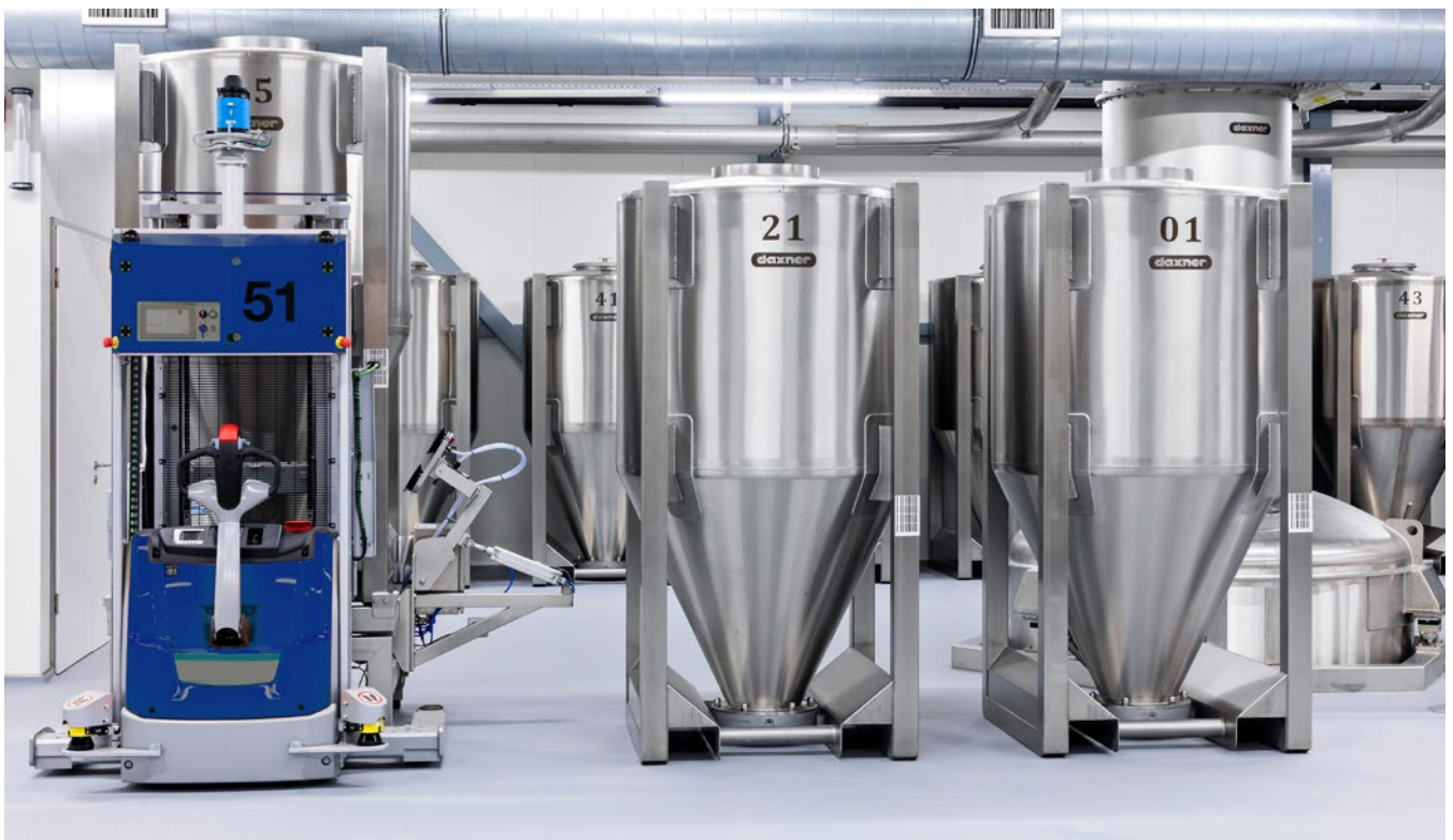
Die Container werden mittels fahrerlosem Transportsystem durch die Anlage bewegt.
