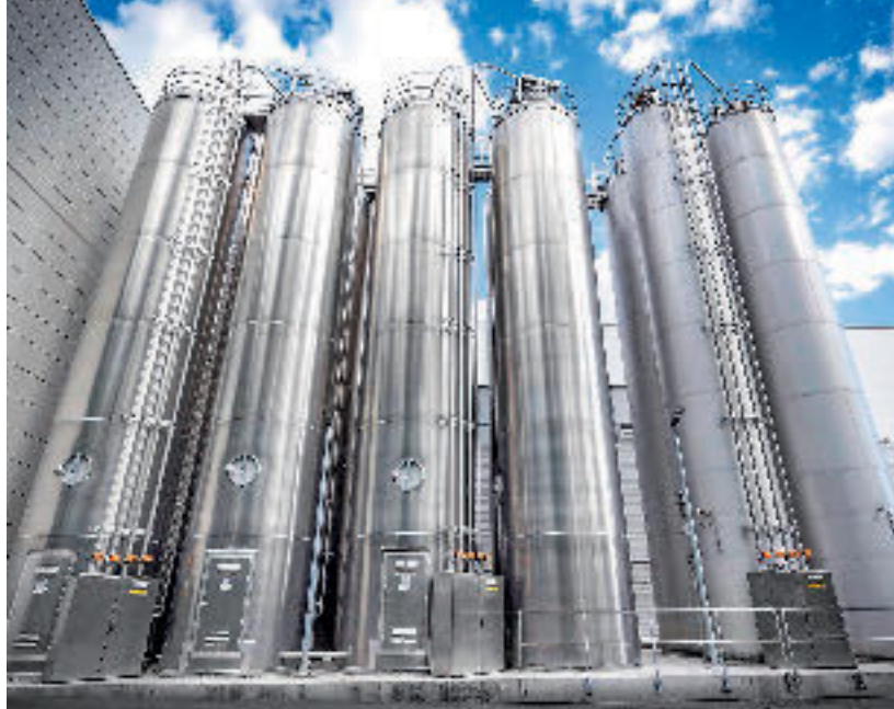
Die Hauptkomponenten werden in Außensilos gelagert und pneumatisch den Mischlinien zugeführt
