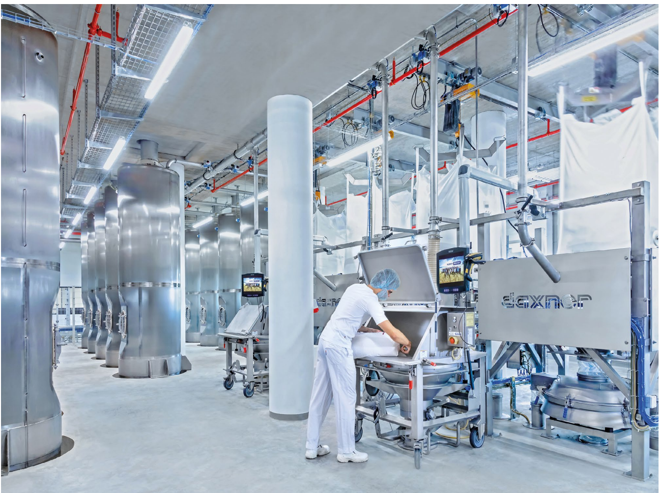
Sackaufgabestation zur staubarmen Sackentleerung
