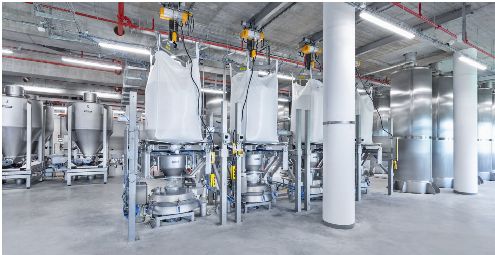
Big-Bag Entleerstationen mit integrierter Flachsiebmaschine
