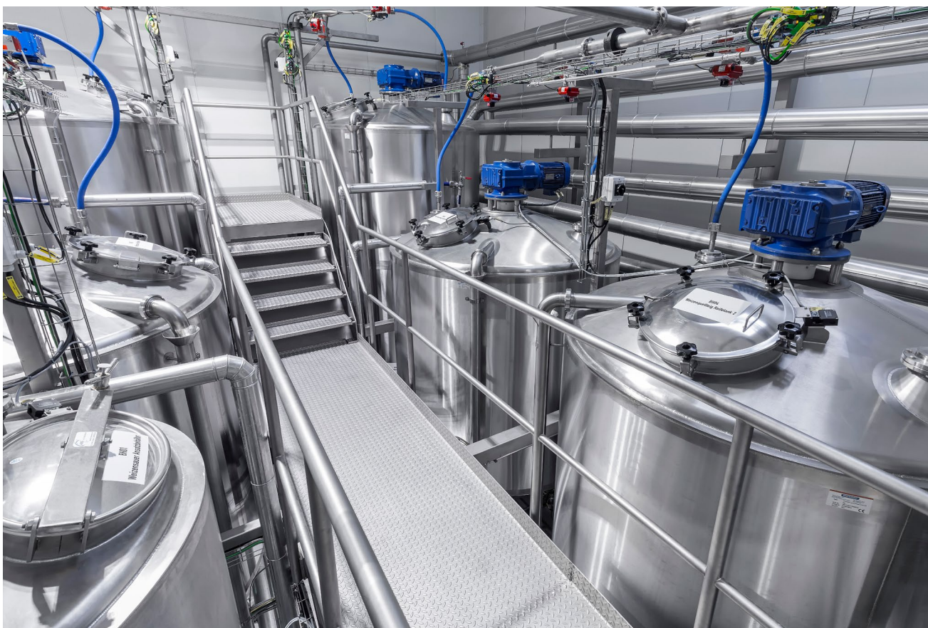
Lagerbehälter inkl. Rührwerk
