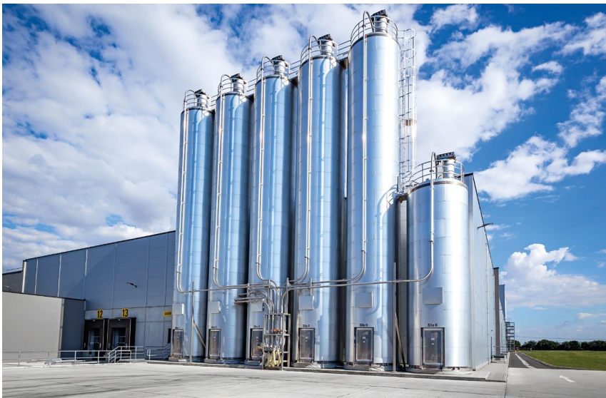
Die Außenlagersilos werden pneumatisch durch Silofahrzeuge befüllt.
