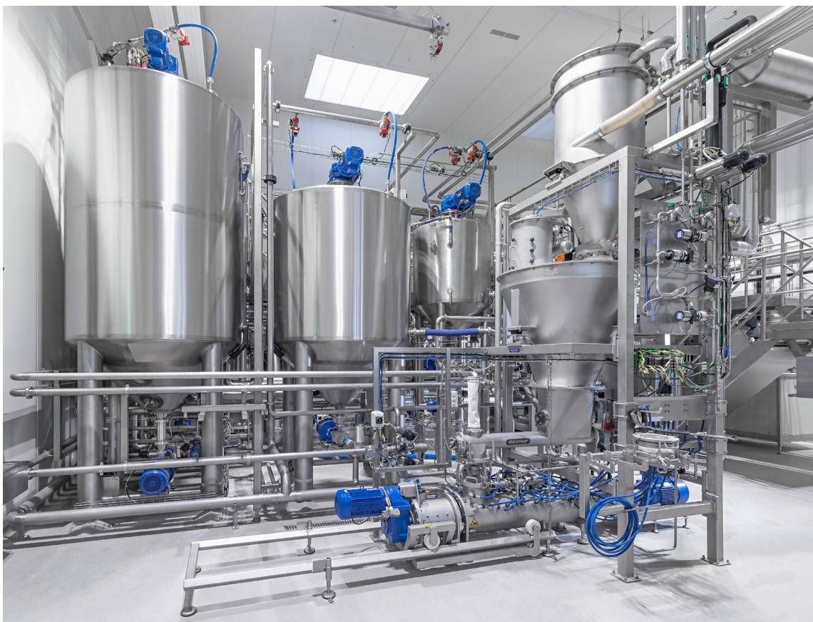
Sauerteiganlage inkl. Anteiger zum homogenen Mischen von Mehl und Wasser
