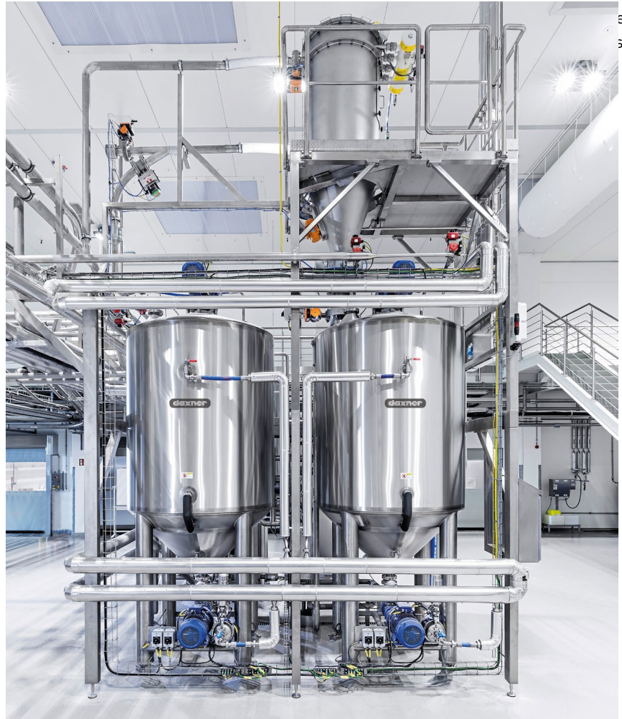
Quellstückanlage mit Quell- und Lagertank
