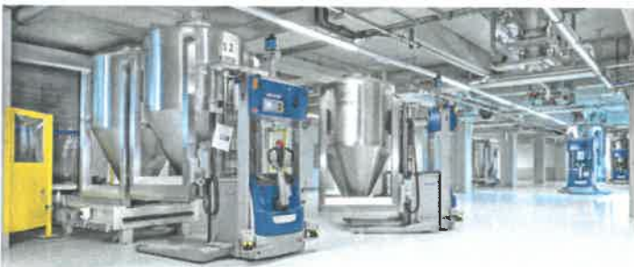
Abb. 5: Ein fahrerloses Transportsystem (FTS) bewegt die Container durch die Anlage.
