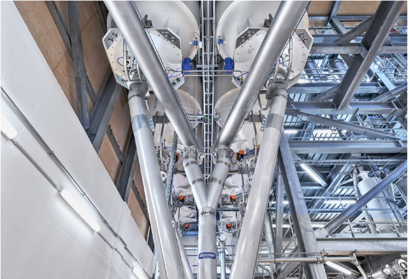
24 Silos sorgen für Flexibilität
