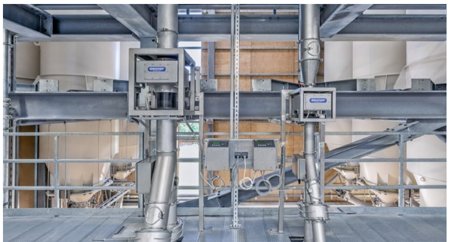
Metalldetektoren für sichere Endprodukte
