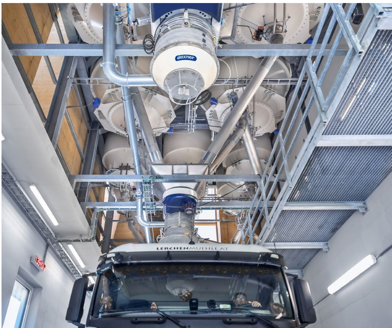
Staubfreie LKW-Verladung in der geschützten Verladehalle
