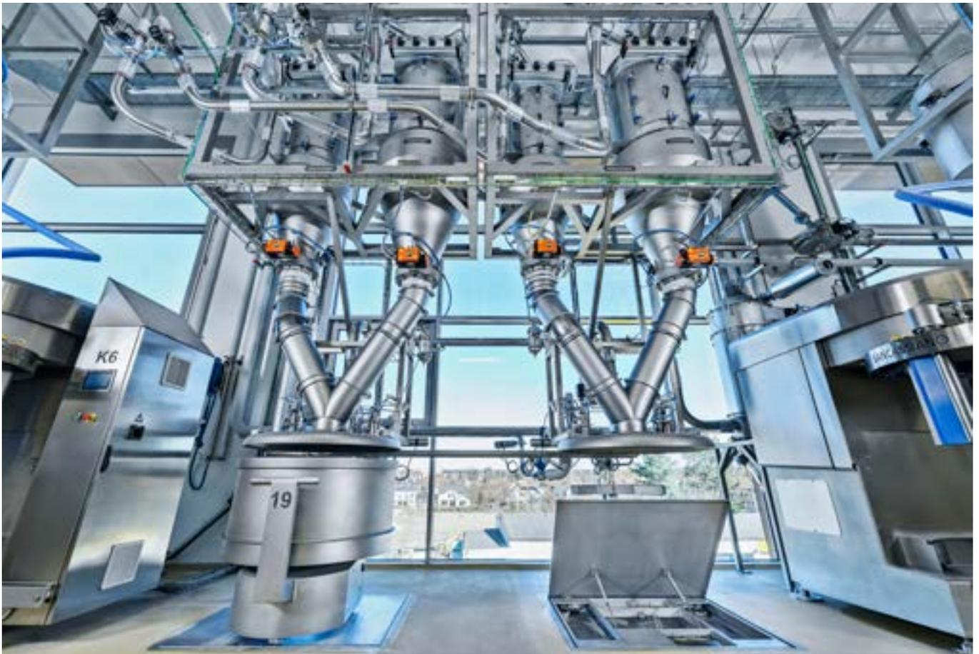
Zentrale Mehl- und Komponentenverwiegestation mit Bodenwaage
