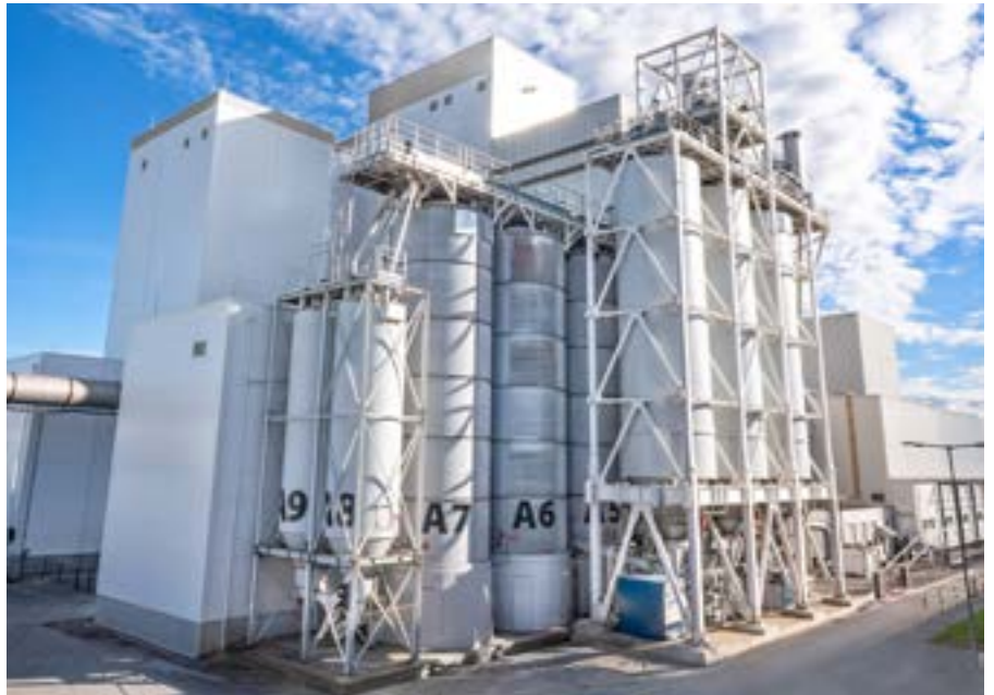
Großkomponenten-Silos im Außenbereich
