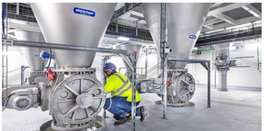
Totalabscheider mit Zellenradschleuse
