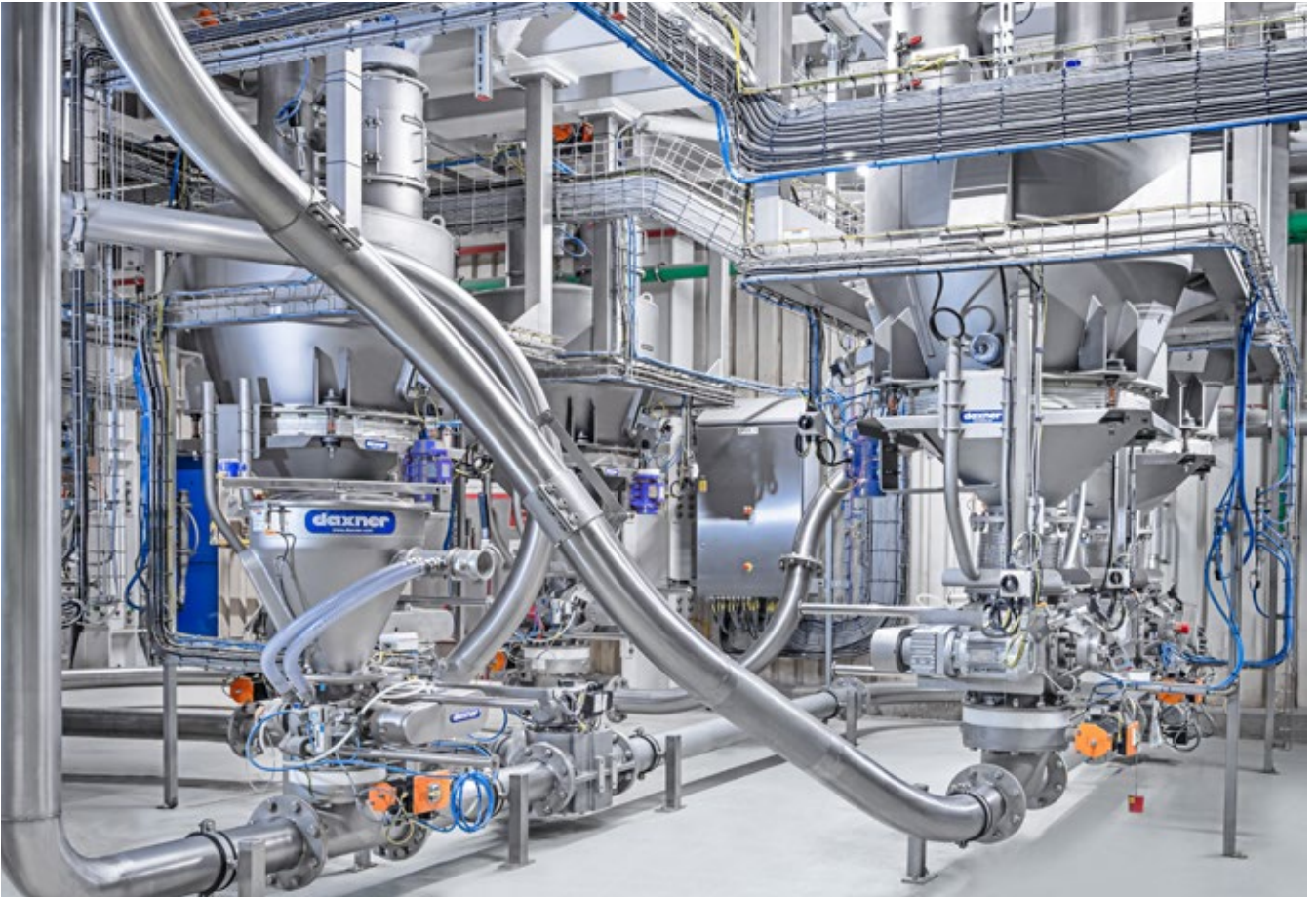
Pneumatische Fördersysteme aus Sendebehälter
